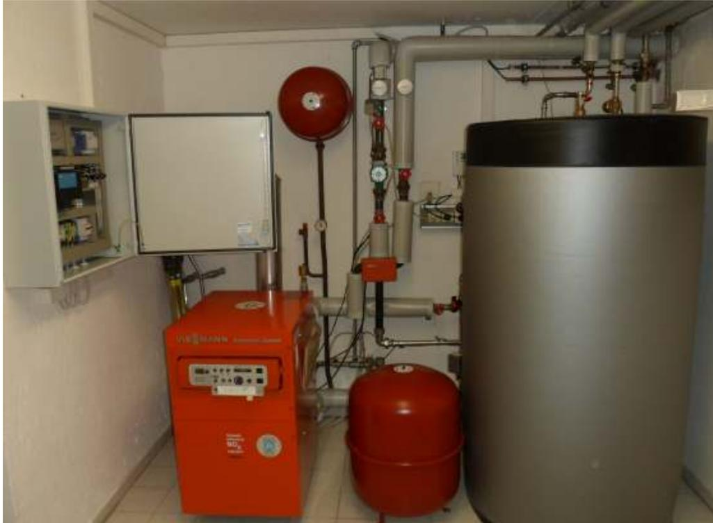
Um den Heizenergieverbrauch aus Primärenergieträgern (Holz, Gas, Heizöl u. Strom) zu reduzieren, verwenden wir die erneuerbare Energie aus einer PV-Anlage (Windkraft, Wasserkraft ebenso möglich), um mit deren Hilfe und einer Regelung, die so erzeugte Energie in thermische Energie umzuwandeln, um sie in einem Warm-Wasser-Pufferspeicher zu speichern.
