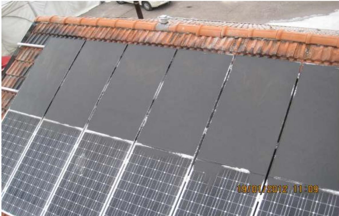
Die Feuerwehren haben hier ein Problem, dass z.B. bei Schwelbränden unter der Dachhaut, diese nicht gefahrlos gelöscht werden können. Sie müssen jederzeit mit gefährlichen Stromschlägen, 1000 Volt Gleichstrom, rechnen.
