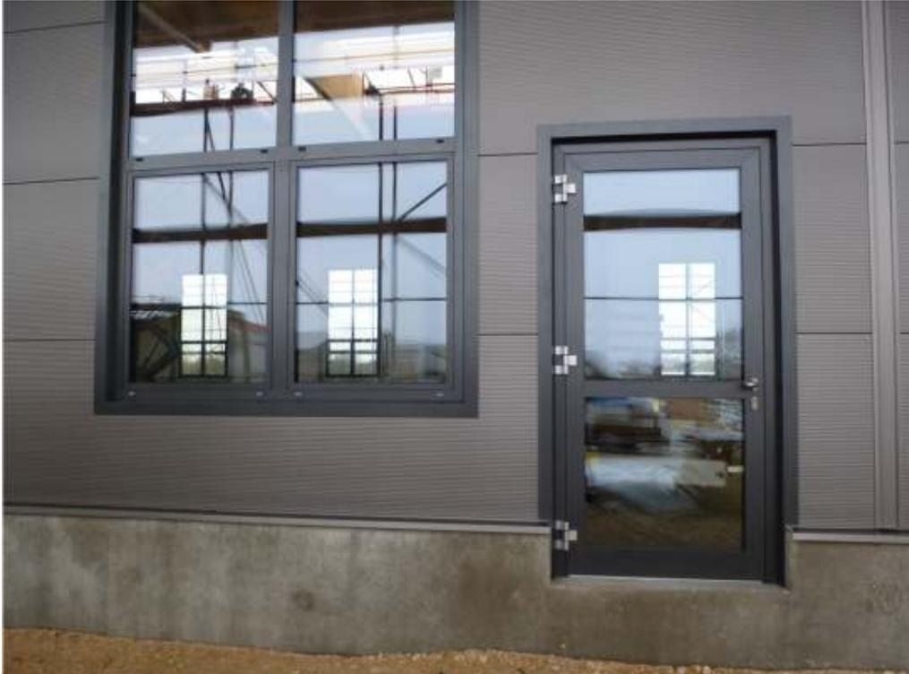
Durch ein einzigartiges Fenster- und Türensistem kann man in sogenannte Sandwichpaneele (0,6 mm Blechschale innen + außen, dazwischen PU Schaum) Fenster und Türen komplett ohne Schraubverbindungen einbauen.
