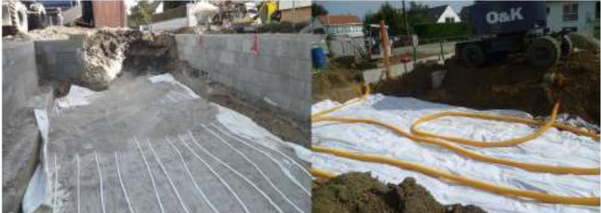
Optimierung der Erdreich-Kollektorfläche von Sole-Wärmepumpen.
