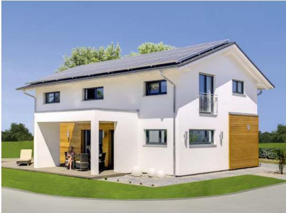
Das Basic Line Jubilée XXL Plus von Haas Fertigbau ist ein Effizienzhaus Plus. Mit einer Photovoltaikanlage erzeugt es mehr Strom, als die Bewohner für die Heizung, die Wasserbereitung und den Betrieb elektrischer Geräte verbrauchen. Dank eines Solarspeichersystems können die Bewohner die erzeugte Solarenergie dann nutzen, wenn sie gebraucht wird. Der erzeugte Stromüberschuss kann ins öffentliche Netz eingespeist werden.
