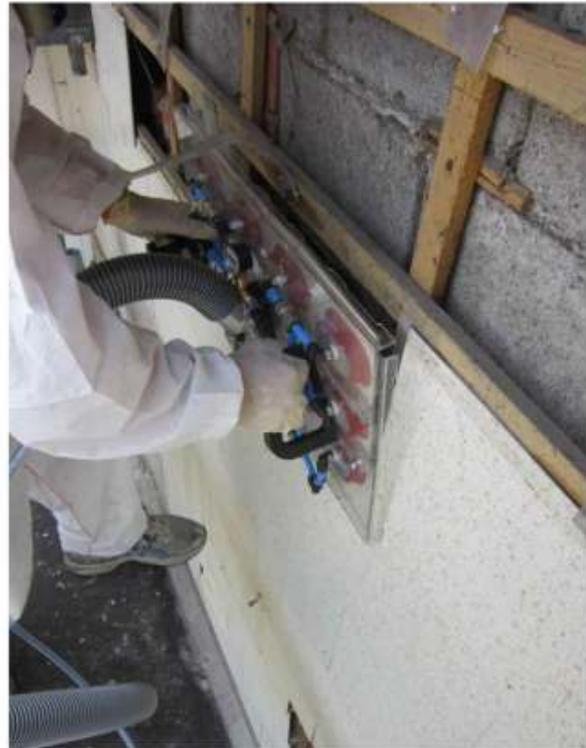
Unser Demontagegerät verhindert, dass die asbesthaltigen Fassadenplatten (60 x 30 cm) beim Abbau brechen und gefährliche, krebserregende Asbestfasern in die Umwelt gelangen und somit die am Objekt tätigen Arbeiter und die Anwohner bzw. Passanten nicht gefährden.
