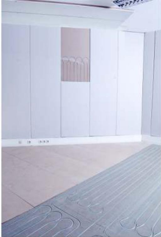
Ziel der Entwicklung von KRAUTHÖFERthermoflair - der patentierten Systemheizung - war, eine möglichst einfache und kompakte Produktlinie zu schaffen. Diese soll sowohl an Wand, Boden und Decke - nachträglich - in Bestandsbauten zur energetischen Sanierung - auf Niedertemperaturniveau - eingebaut werden können.
