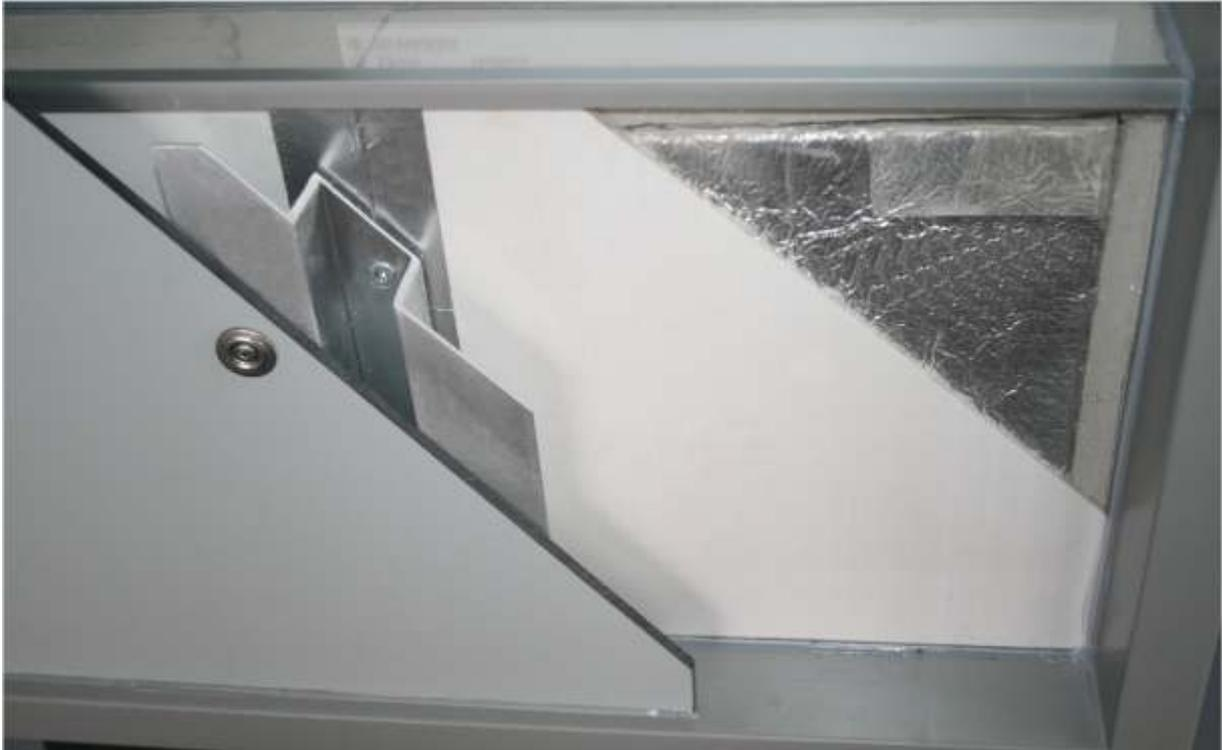
Die QASA-B1-Vakuumdämmung ist ein extrem schlankes Dämmsystem für vorgehängte hinterlüftete Fassadenkonstruktionen (VHF). Im Vergleich zu herkömmlichen Dämmsystemen besteht die QASA-B1-Vakuumdämmung mit um Faktor 5 schlankeren Dämmdicken (ca. 100 mm Gesamtstärkenaufbau inkl. Hinterlüftungsebene und Bekleidungsplatten).
